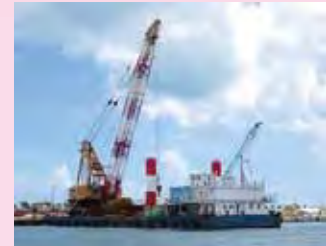
施工クレーン台船 洋上施工を低炭素化・ 高効率化する新たな施 工手法等を確立
