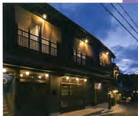
有馬源泉プロジェクト-I 火災で焼失した建物を再建、2階は宿泊施設
