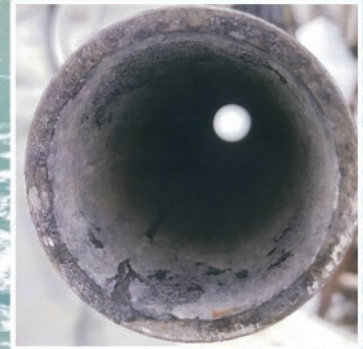
取替後 特殊処理配管 設置から2ヶ月経過
