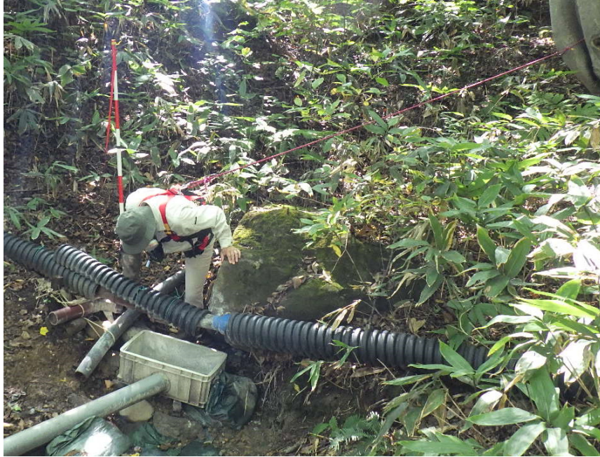
ハーネス型安全帯とロープによる墜落防止措置
